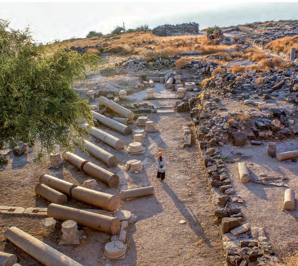
Afb. 6. De acht zuilen, die het zuidelijke deel van het middenschip droegen van de basiliek van Hippos, zijn door de aardbeving van AD 749 opvallend parallel in zuidwestelijke richting neergevallen. Foto: bewerkte opname van het Hippos-Sussita Excavation Project; www.ukmediawatch.org .
